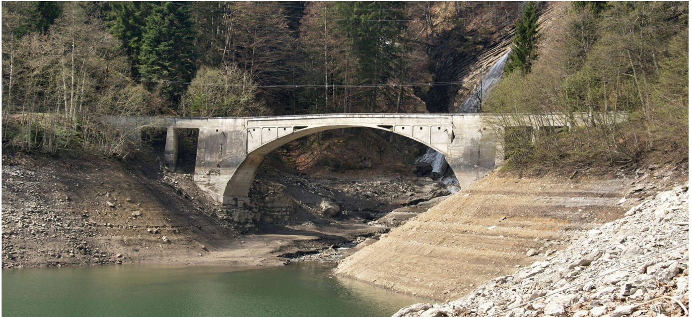
01 Schrähbachbrücke (1924), Innerthal SZ (Foto: KEYSTONE/Markus Widmer)
