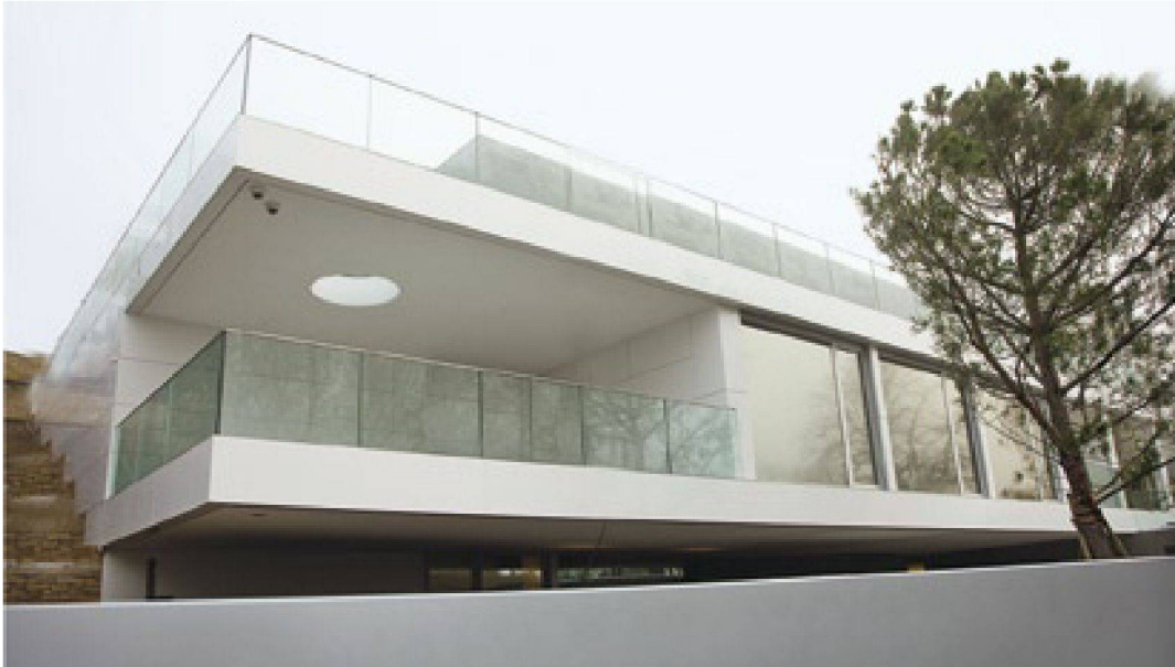
01 Aussenansicht. Durch die runde Öffnung fallen die Lichtreflexionen des darüber liegenden Swimmingpools auf Boden und Wände der Loggia
