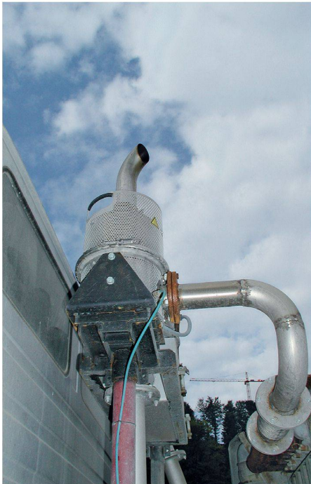
Eine schwere Baumaschine im Einsatz für den Üetlibergtunnel: Die Notwendigkeit, die Arbeiter vor den Abgaswolken zu schützen, gab den Anstoss für die Empa-Studie (Foto: Empa)
