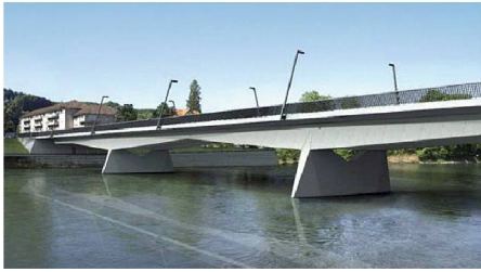
03 «Tangram»: Die vorgespannte Brücke ruht auf zwei stark gevouteten Längsträgern (niedrige trapezförmige Vollquerschnitte, Hohlkästen zu den Pfeilern hin). Die Aussenflächen erscheinen entlang einer schräg verlaufenden Knicklinie gefaltet
