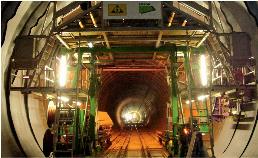
01 Das Tecton-Hotmeltssystem im Einsatz im Wienerwald-Tunnel (Foto: Tecton AG)
