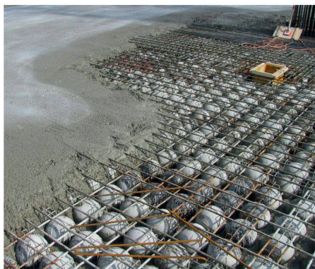
01 Hohlkörper aus recykliertem Polyethylen ermöglichen bis zu 30% leichtere Betondecken (Foto: MCH Messe Schweiz [Basel] AG)
