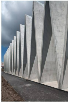
Expressiv: das Betonfaltwerk des Sportausbildungszentrums Mülimatt in Brugg/Windisch (Foto: Alexandre Kappelos)
