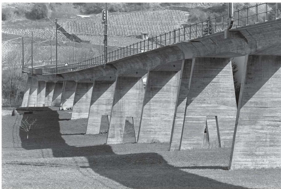
01 Viaduc de Sembrancher VS (1953), Alexandre Sarrasin: Beim Eisenbahnviadukt von Sembrancher zeigt sich Sarrasins undogmatisches Streben nach Anpassung eines Konzepts an lokal wechselnde Bedingungen besonders deutlich. Der leicht ausgebildete Betonträger ruht auf A-förmigen Stützen, die seine seitliche Stabilität gewährleisten. Beim Überqueren der Sankt-Bernhard-Strasse ziehen sich diese Stützen gleichsam zusammen, um der Strasse mehr Raum zu geben, in der Kurve neigen sie sich asymmetrisch gegen das Kurveninnere (Foto: Martin Linsi)
