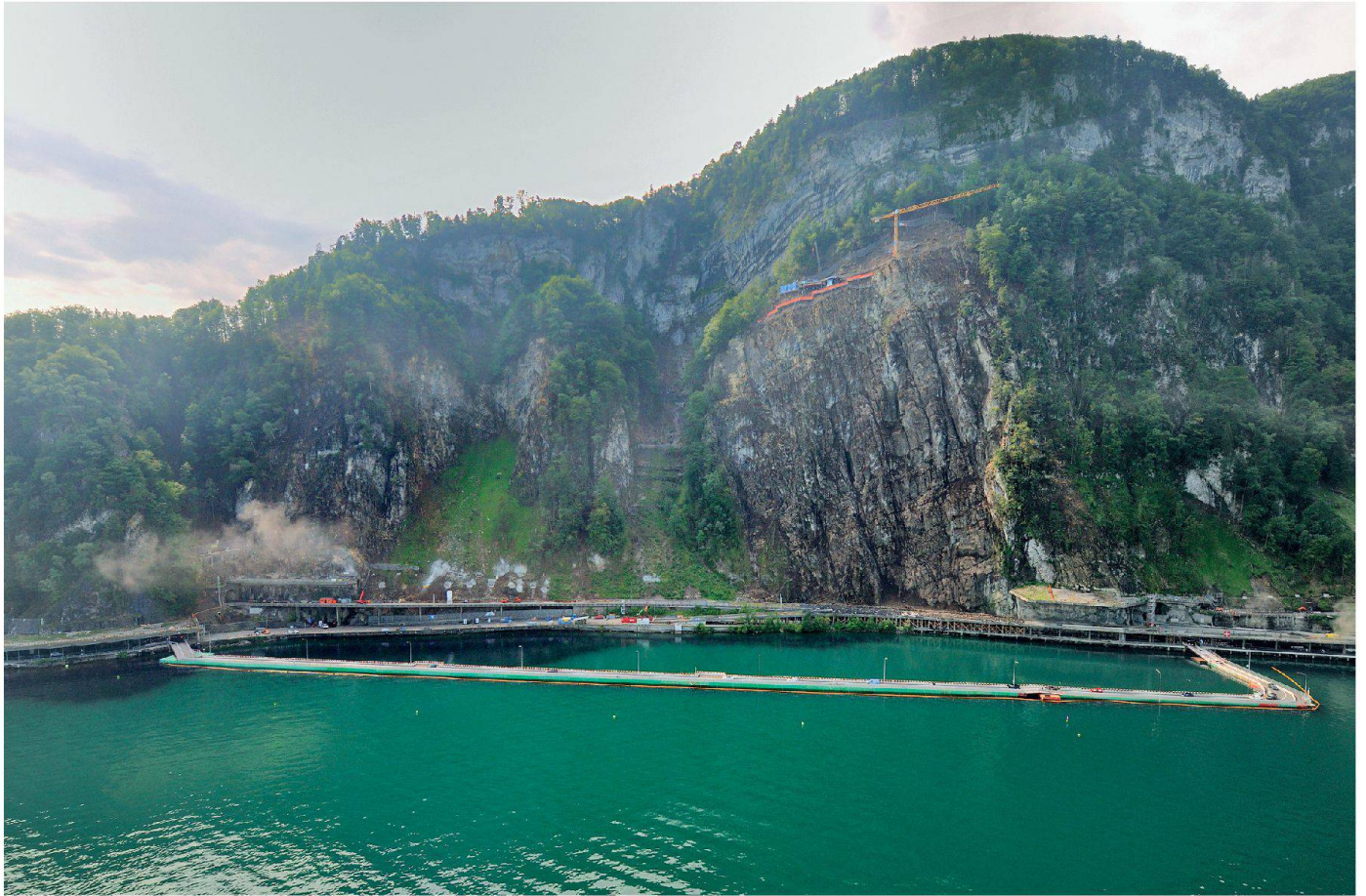
02 Lopperviadukt mit dem Reigeldossen und der Arbeitsplattform in der Bildmitte (Foto: Astra)
