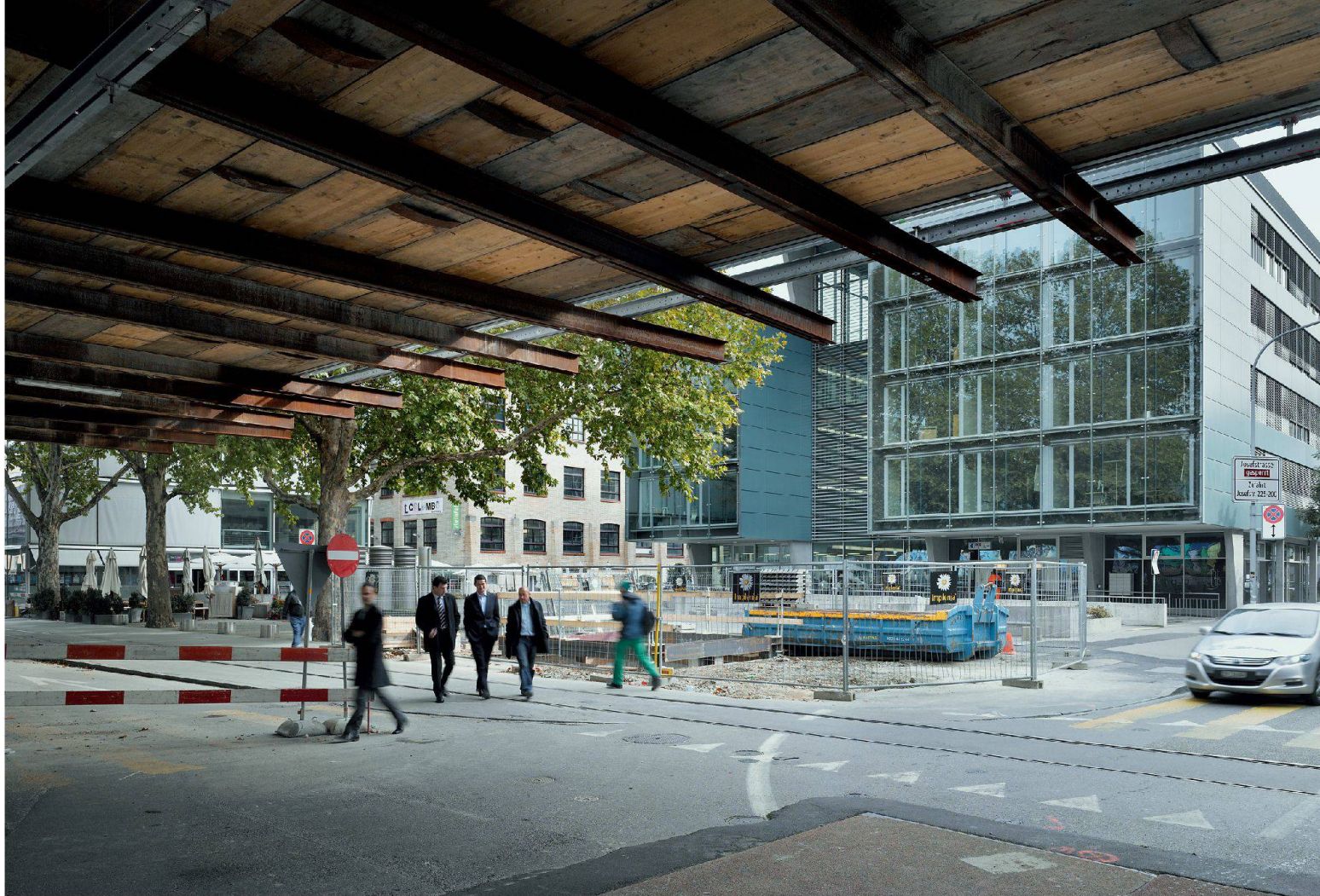
01 An der Hardstrasse im Zürcher Industriequartier, wo die Hardbrücke saniert und eine neue Tramlinie gebaut werden (Fotos: Hannes Henz)
