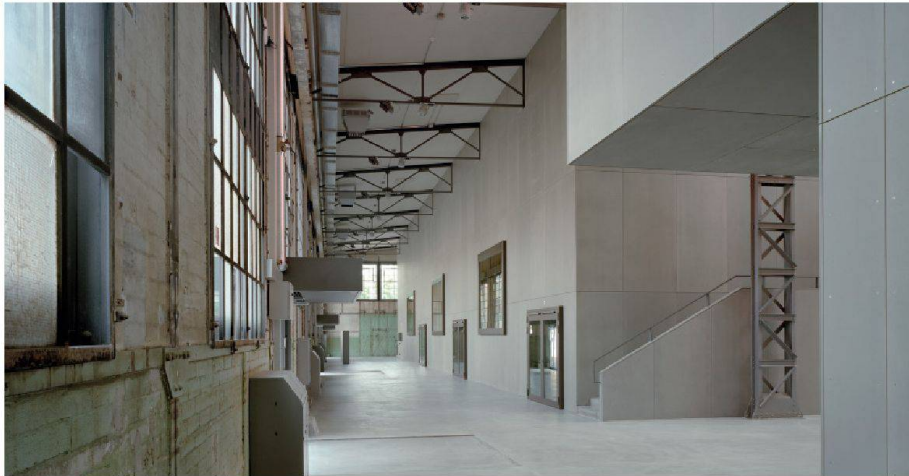
01 Bei der zum Hörsaalkomplex der Uni Bern umgebauten ehemaligen Weichenbauhalle dient der Raum zwischen alter Hülle und neuem Einbau als Klimapuffer (Foto: Walter Mair)
