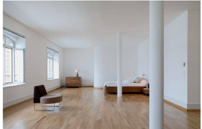
04 Wohnung im 4. Obergeschoss. Hier setzte Maillart statt der Pilzstützen Holz- bzw. Betonstützen ein, die im Zuge des Umbaus erneuert wurden
