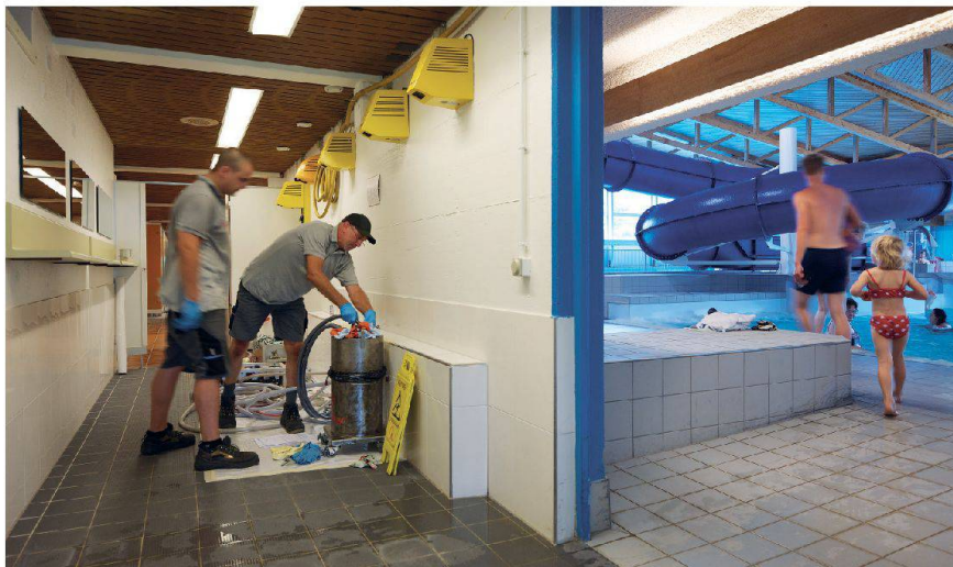
Rohrrinnensanierung mit HAT-System: Keine Baustelle. Kein Aufreissen. Kein Bauschutt. Kein Lärm. Also auch keine Betriebsunterbrechungen.
