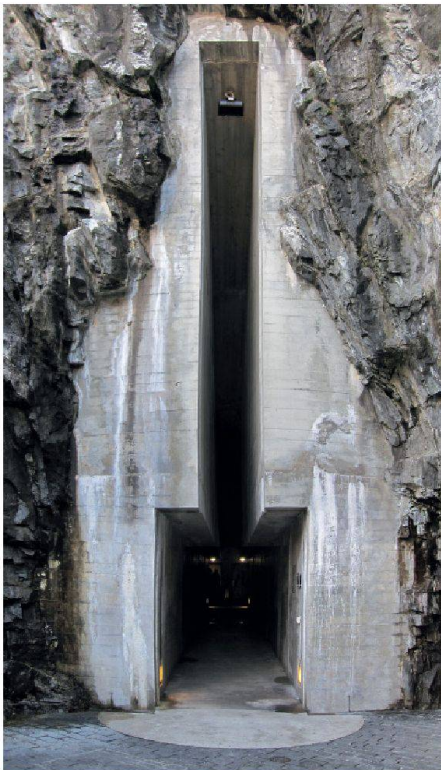
11 Aurelio Galfetti, Castelgrande Bellinzona, Liftschacht der Vertikalverbindung zwischen Burg und Stadt, 1982–2000, deren eigentümlicher Akustik eine subjektive Beschreibung nicht gerecht zu werden vermag (Foto: Anna-Lena Walther)
