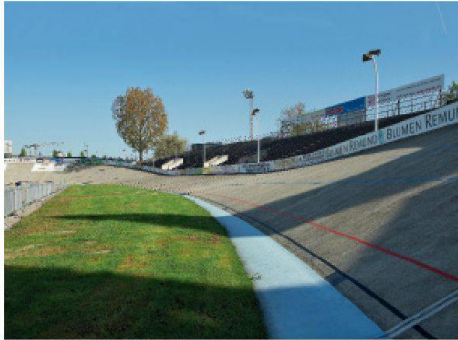
Unterschätzter Raum: im Betonoval der 100-jährigen offenen Rennbahn Oerlikon (Foto: Theodor Stalder)
