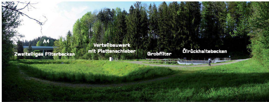
01 Panoramaansicht der Öko-SABA Wässermatt der A4 im Raum Hedigen/Zwillikon (bei km 46.6) mit grossem Einzugsgebiet (ca. 33 ha) und langer Transportleitung vom Tiefpunkt zur SABA, entwässert via Jonen in die Reuss (Projekt: ewp AG, Effretikon) (Foto: Peter Sulser)
