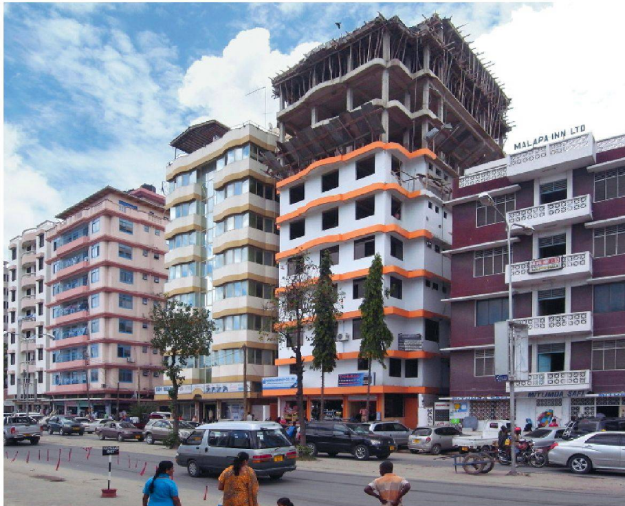
01 Strassenzug in Daressalam mit einer typischer Aufstockung (Fotos: Benedikt Boucsein)
