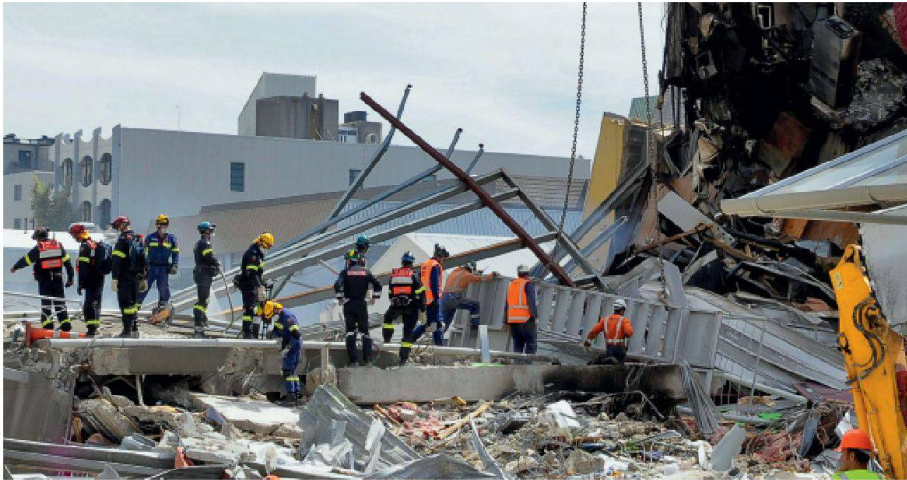
01 Während des Erdbebens vom 22. Februar 2011 stürzte das CTV-Gebäude in Christchurch ein. (Foto: Keystone, AP Photo/Rob Griffith, File)
