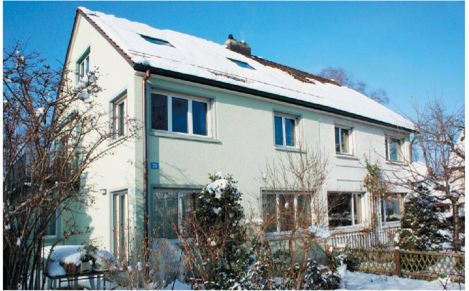
01 Optisch ist zwischen der sanierten, vorderen Doppel-Einfamilienhaushälfte fast keine Unterschied auszumachen gegenüber der hinteren unsanierten Hälfte. (Fotos: Autor)
