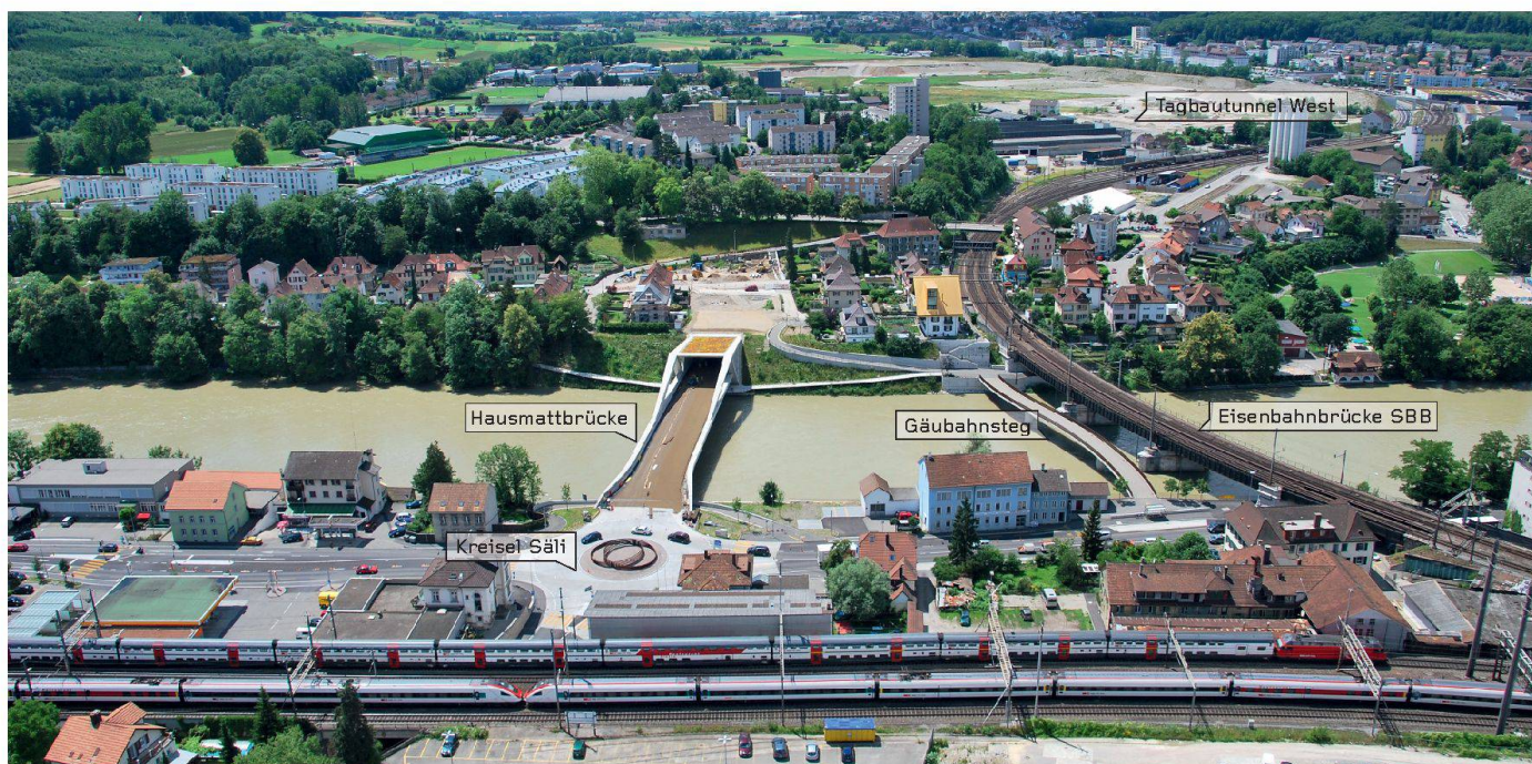
01 Mit dem Kreisel Säli in Olten wird die neue Entlastungsstrasse an die Aarburgerstrasse angebunden. Anschliessend überquert die 15.60 m breite und 88.50 m lange neue Brücke die Aare stützenfrei und mündet direkt in den 390.50 m langen Hausmatttunnel. Die Entlastungsstrasse unterquert im bergmännisch erstellten Tunnel das Wohnquartier Kleinholz und führt dann weiter Richtung westlicher Stadtrand, nach Wangen und Rickenbach. (Foto: Amt für Verkehr und Tiefbau, Kanton Solothurn)
