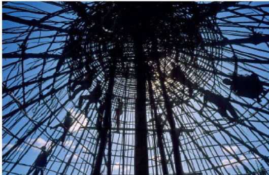
Handwerker konstruieren das Dach eines traditionellen Rundhauses im ländlichen Äthiopien. (Foto: Keystone/Photonostop/Bruno Barbier)
