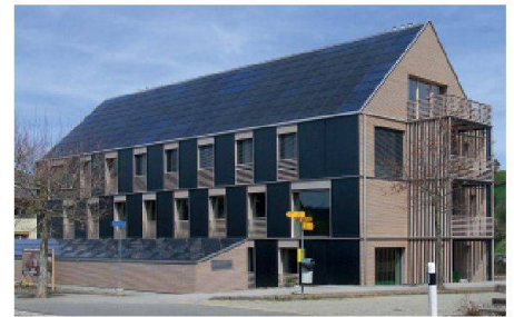
01 Kraftwerk B in Bennau SZ. Architektur: Josef Grab, Sanjo Immobilien AG; Energiekonzept: Amena AG, Winterthur. Der Mittelgiebel war eine Vorgabe der Baubehörde.
