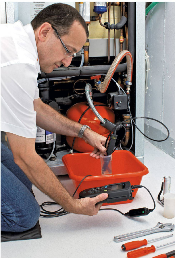
Sorgfältige Wasseranalyse vor der Sanierung.
