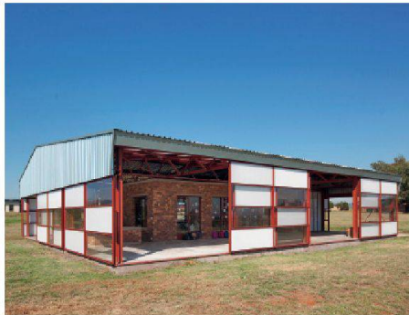
Kindergarten für das Ithuba Community College südöstlich von Johannesburg: Der innere Backsteinbau ist von einer Stahlkonstruktion mit Schiebetüren umgeben, die einen überdachten Raum abtrennt. (Foto: Leon Krige)
