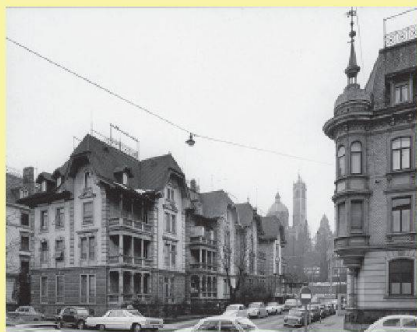
02 Die Venedigstrasse vor dem Abbruch (Foto: Baugeschichtliches Archiv Zürich)
