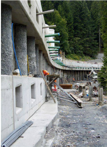
01 Hangsicherung Schin: H 417a Thusis – Tiefencastel; Bauherrschaft: Kanton Graubünden, Projektierung: Dr. Vollenweider AG, Zürich. (Foto: Roman Richner, Zürich)
