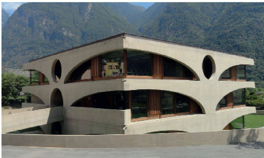
Schulhaus und Kindergarten Grono: Eine abfallende Rampe führt in den Kindergarten im EG, eine Brücke auf der gegenüberliegenden Gebäudeseite zum Eingang der Schule im 1. OG. (Foto: Wikimedia / Parpan05)
