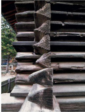
Die Konstruktion des Shosoin in Nara (J) regelt die Temperatur durch das Quellverhalten des Holzes: An trockenen Tagen öffnet sich ein Schlitz zwischen den Bohlen, an feuchten Tagen schliesst er sich. (Foto: ms)
