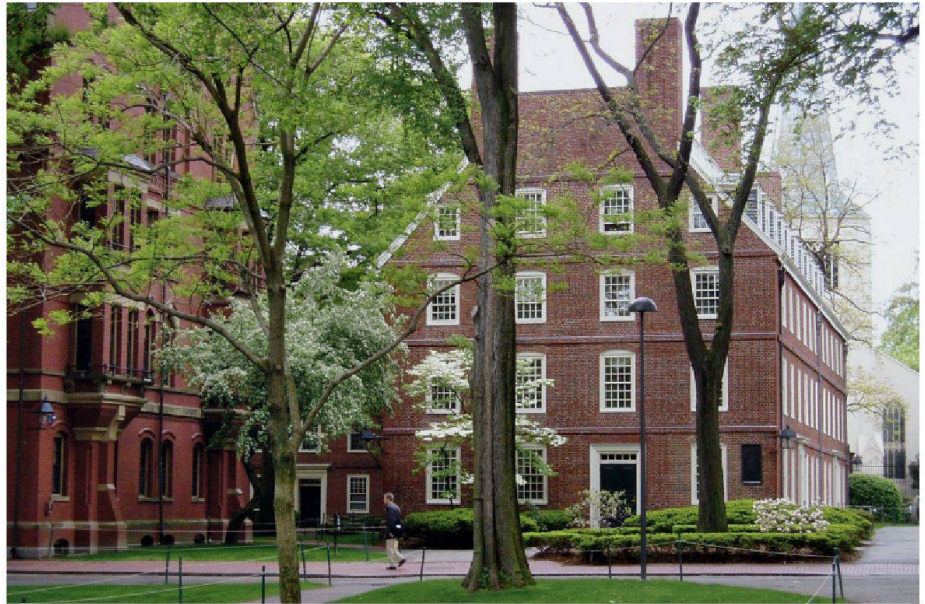
Ein grosser Teil der Gebäude auf dem Harvard Campus ist denkmalgeschützt. Für deren energetische Sanierung wird nun eine Innendämmung mit einem von der Empa entwickelten, aerogelbasierten Dämmputz getestet. (Bild: Wikipedia/Muns)
