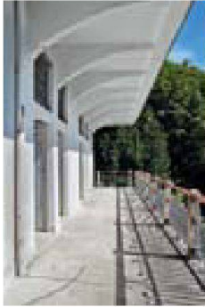
Das Tragwerk des Herrenhauses Hauteroche in Le Pont ist zugleich das architektonische Erscheinungsbild des bautechnisch hochwertigen Bauwerks. (Foto: Clementine van Rooden)
