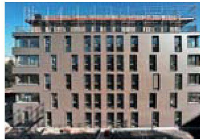
5 immeubles de 120 logements Minergie, Lausanne VD Eingereicht durch | Présenté par | Inoltrato da: farra & zamboulakis architectes sarl, Lausanne
