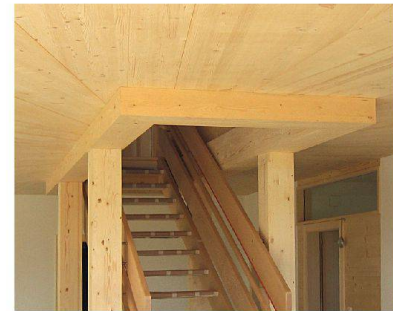
Geschossdecke mit GFP von Schilliger.
