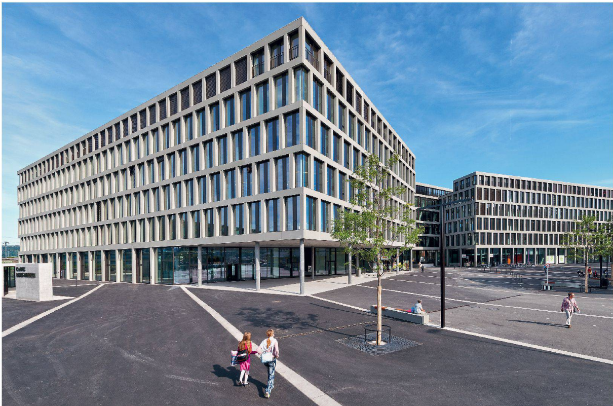
Die beiden Voluma des Neubaus der FH Nordwestschweiz am Bahnhof Brugg. Von aussen lassen sie nicht erahnen, was hinter ihrer Fassade steckt – es könnte genauso gut ein Spital, ein Hotel oder eine Stadtverwaltung sein.
