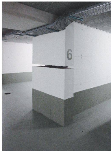
Endzustand: Der Schlitz durch die Stahlbetonwände wurde sichtbar gelassen. Die beidseitig angelegten Parkboxen bieten Platz für je ein Auto.
