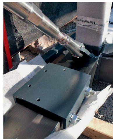
Anschlussdetail der Carbonträger.
