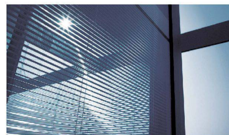
Sonnenschutz der Zukunft: ins Isolierglas integrierte Jalousie.
