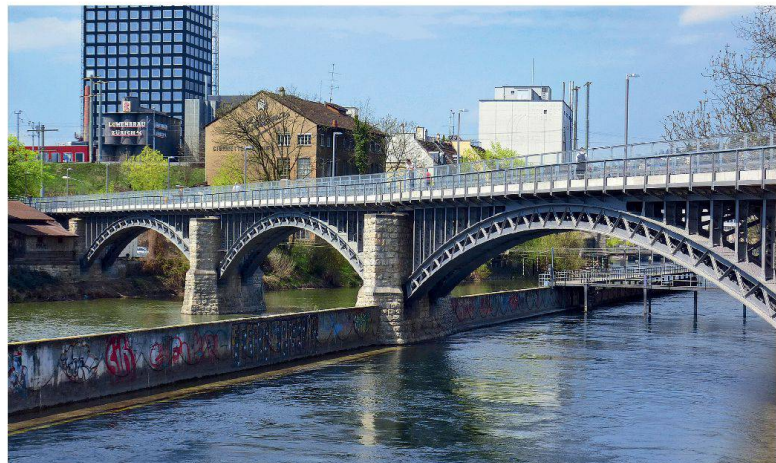
Blick flussabwärts auf die instandgesetzte Limmatbrücke.
