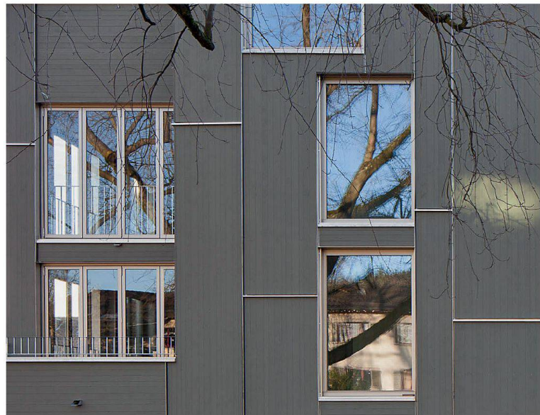
Armon Semadeni und Michael Meier Marius Hug Architekten: Holzfassade des Hauses mit Alters- und Invalidenwohnungen in Wintertur ZH.
