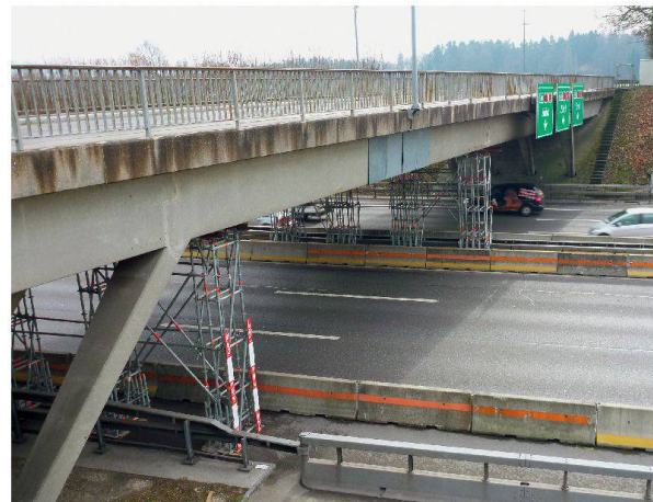
Die Sicherung besteht aus Gerüsten mit Anprallschutz auf den Mittel- und Pannenstreifen sowie Abdeckblechen beim Schaden.
