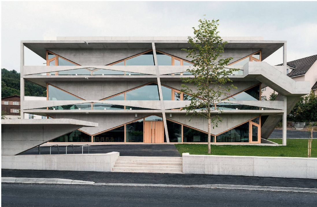
Die Fassade ist expressiv, ohne formalistisch zu sein: Der gezielte Materialeinsatz und die Gegensätze massiv-flüchtig ergeben sich aus den Kraftflüssen. Sämtliche Bauteile der äussersten Schicht des Gebäudes sind tragend ausgebildet.
