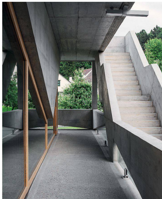
Balkon und Fluchttreppe. Die dreieckige Wand scheint zu schweben. Erst im Innern des Gebäudes versteht man die Funktionsweise.
