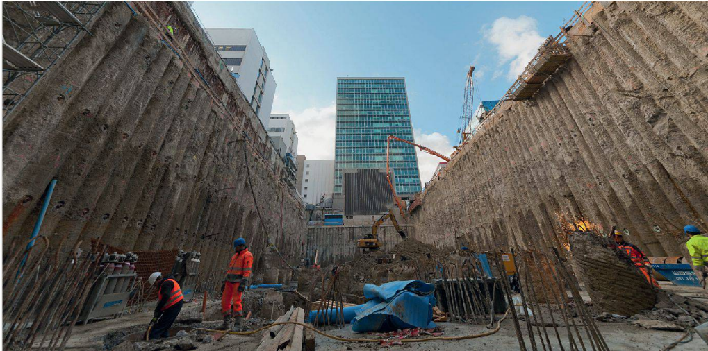
Endaushub der Baugrube für den Roche-Turm im Basler Wettsteinquartier. Im Hintergrund der 62 m hohe Bau 52.
