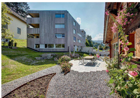
Bei einigen Kriterien sind kleinere Gebäude wie das Mehrfamilienhaus Kirchrainweg in Kriens im Nachteil.
