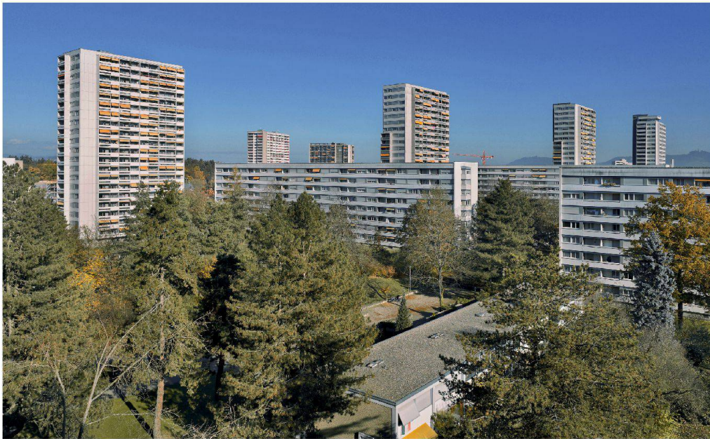
Die Siedlung Tscharnergut im Westen von Bern soll etappenweise so saniert werden, dass sie weiterhin günstigen Wohnraum anbieten kann. An einem der Gebäude wird das Vorgehen exemplarisch erprobt.
