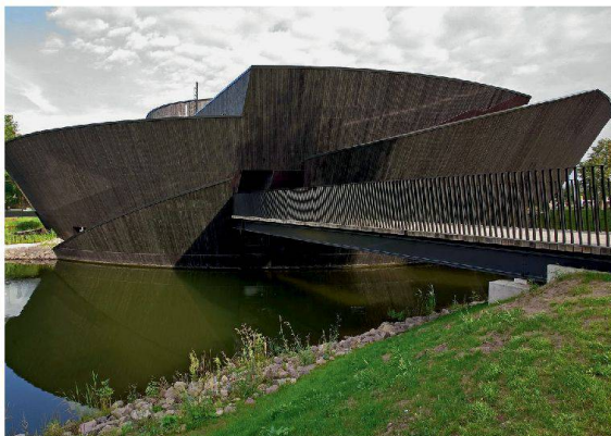
Einzelne Gebäudeteile des Natur-Erlebnis-Zentrum Müritzeum bei Warten stehen in einem Teich.
