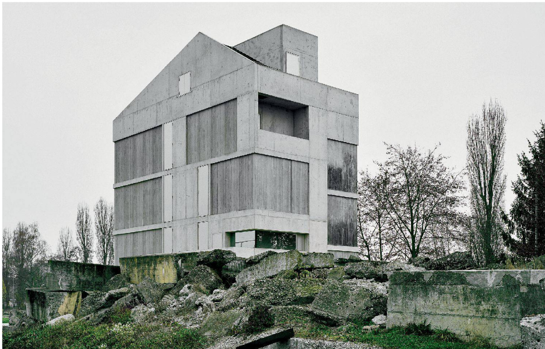
Die Fensterläden fügen sich diskret in die Fassade mit den Fertigbetonelementen und dem Ortbeton dazwischen. Einzig der Kontrollraum im Erdgeschoss ist verglast.
