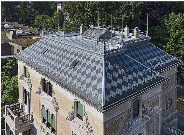
Das fachgerecht sanierte Dach der Villa Patumbah.
