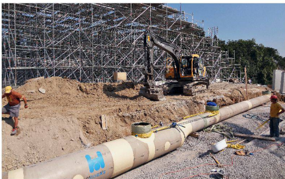
Verlegung der Lüftungsröhren von Hobas.
