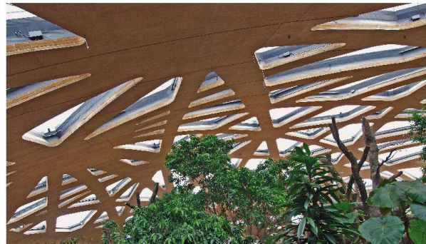
Der Ringbalken aus Beton mit Sika® ViscoCrete® Fließmittel stützt das 1500 t schwere Holzdach.
