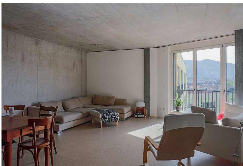
Skelettbauweise mit Sichtbetondecken: Blick in eine Wohnung.
