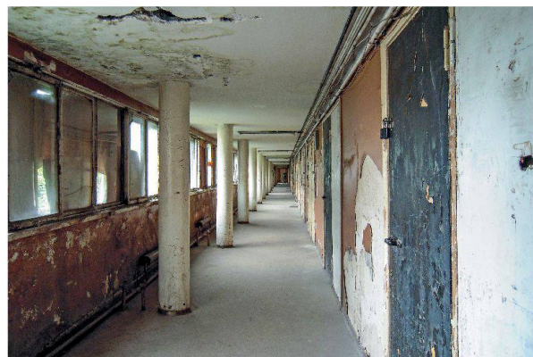
Erschliessungsgang im Narkomfin-Gebäude.
