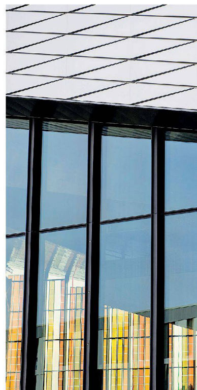
Die Graetzel-PV-Module am SwissTech Convention Center schützen vor Blendung und sorgen für bunte Lichtspiele.
