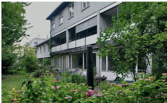
Die Fassade aus den 1960er-Jahren vor der Sanierung mit den alten Eternitbrüstungen und Sonnenstoren.
